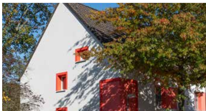
ImmoChance Deutschland 9 Renovation Plus: Bochum – nach Maßnahmen
