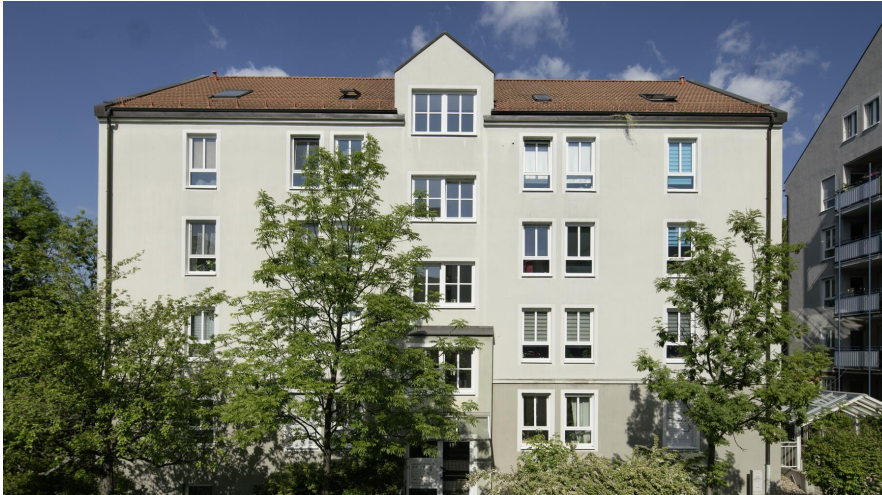
WIDe Fonds 7 Dresden, Lübecker Straße
